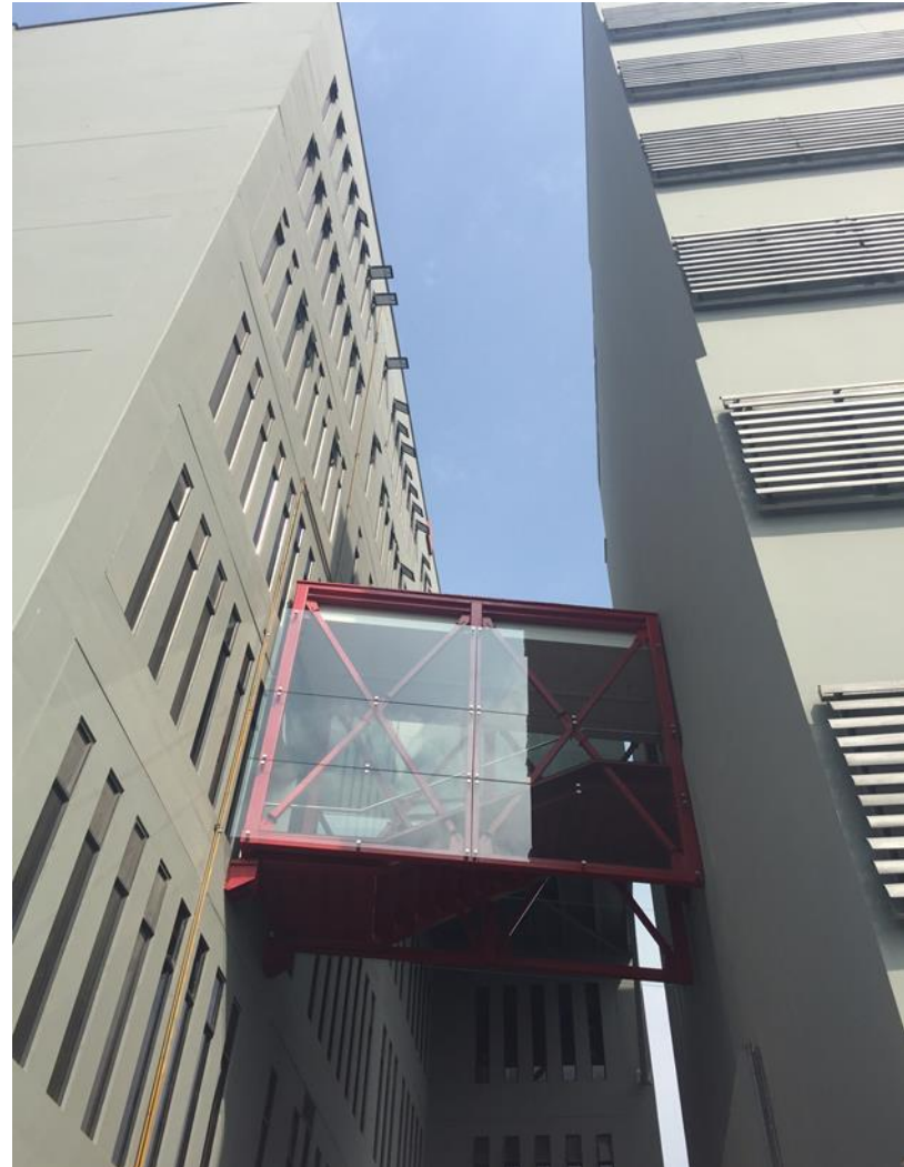
Puente metálico tercer y cuarto piso entre el pabellón A y B
