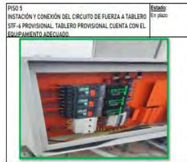
Fotos de Proceso de Obra
